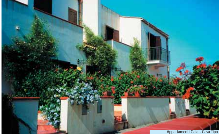
Appartamenti Gaia - Casa Tipo
