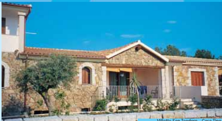
Villette San Teodoro - Casa Tipo
