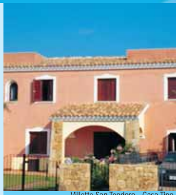
Villette San Teodoro - Casa Tipo
